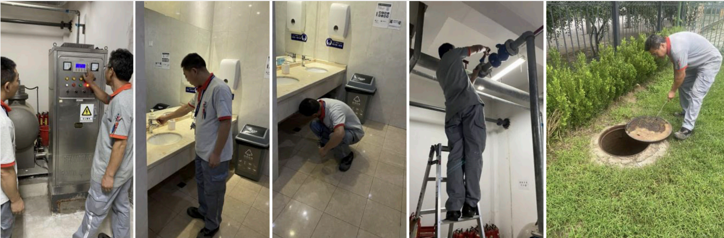
管道漏水应急演练
